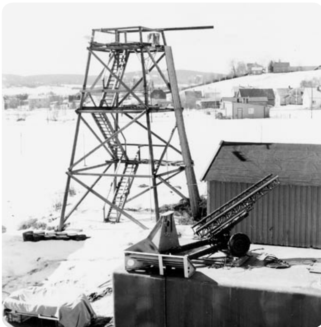
Utpøving av blasterskjermer på FFI 1956
